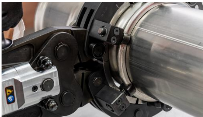
Bilde 35 – Montering av press, 2. fase
