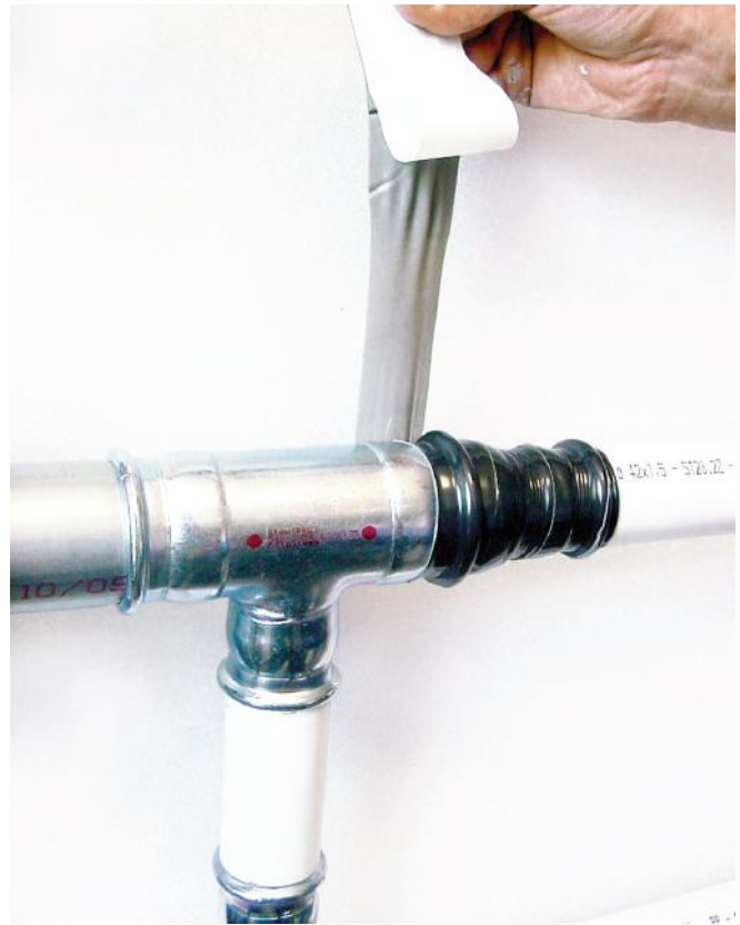
Bilde 38 – Beskyttelse av koblingene med butanoltape.
