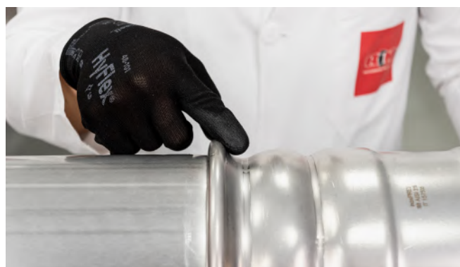
Bilde 36 – Visuell inspeksjon av Oversize-pressing
