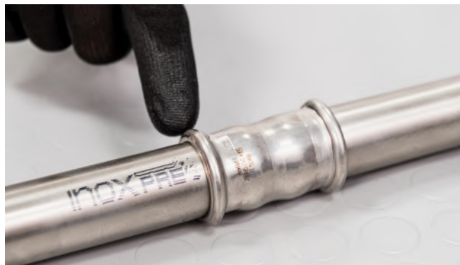
Bilde 33 - Kontroller presskoblingen
