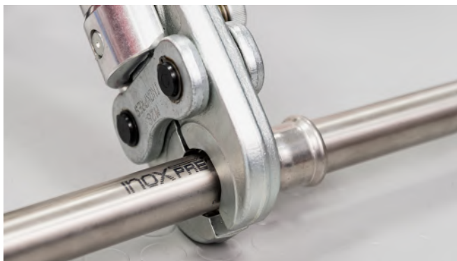
Bilde 32 - Utfør presskoblingen
